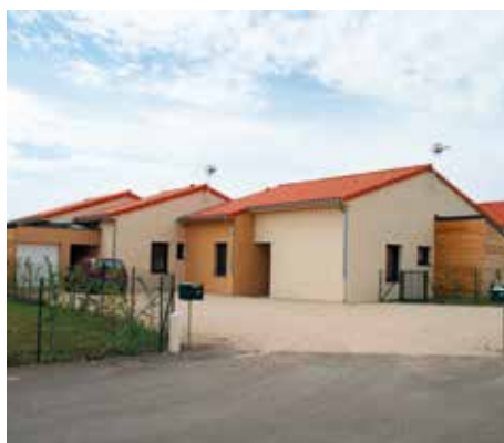
Ces 8 nouveaux logements locatifs se situent dans le lotissement La Crouzette à Bains. Les espaces de vie se prolongent sur d'agréables terrasses-jardins et les logements sont équipés de pompes à chaleur. Architecte : J.C. JUGE.
